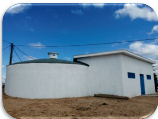
FOTO 6 - REABILITAÇÃO DO RESERVATÓRIO DE CARDANHA (TORRE DE MONCORVO)
