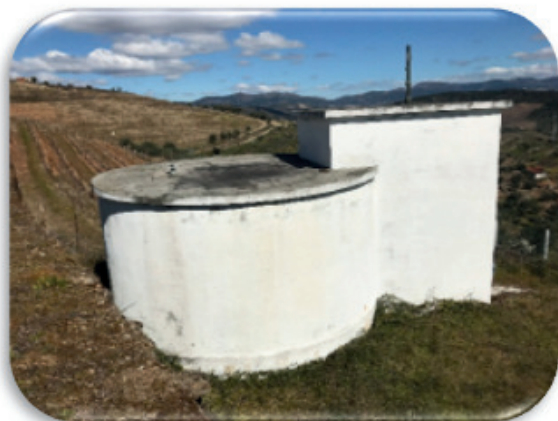
FOTO 7 - RESERVATÓRIO DE PORRAIS (MURÇA)
