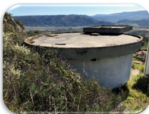
FOTO 5 - RESERVATÓRIO DE HORTA DA VILARIÇA (TORRE DE MONCORVO)
