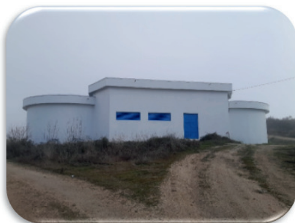
FOTO 1 - REABILITAÇÃO DO RESERVATÓRIO DE CRUZ VILARINHO (TORRE DE MONCORVO)
