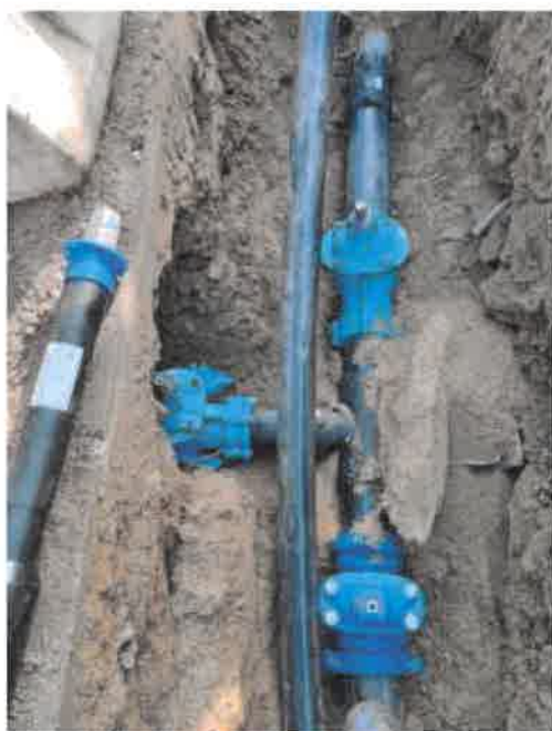
Foto 1 - Reabilitação de rede de distribuição de água
