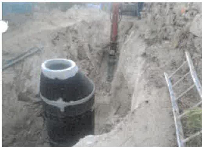
Foto 2 - Instalação de rede de saneamento de água
