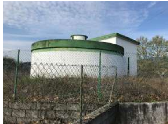
FOTO 2 - RESERVATÓRIO DE BERTELO
