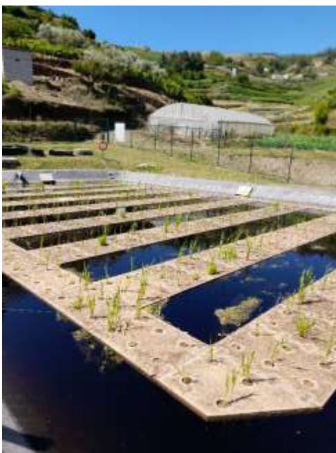
FOTO 4 - ETAR DE TABUADELO
