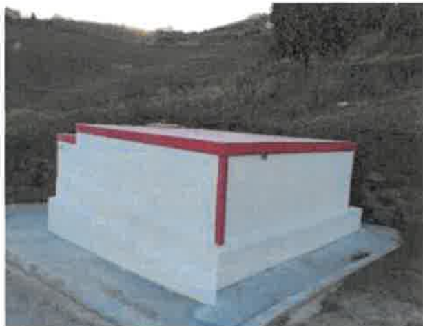
Foto 2 - Reservatório do Vale
