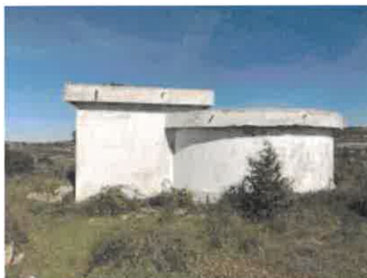
Foto 1 - Reservatório de Estevais
