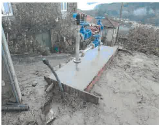
FOTO 2 - FECHO DE SISTEMAS DE ÁGUAS RESIDUAIS EM VÁRIOS LIGARES DOS MUNICÍPIOS DE VILA REAL E SANTA MARTA DE PENAGUIÃO
