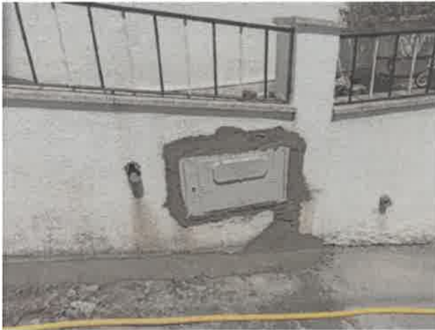
Foto 5 – Reabilitação de rede de distribuição
