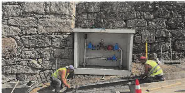
Foto 2 - Instalação de Válvula Redutora de Pressão
