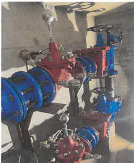
Foto 4 – Execução de válvulas redutoras de pressão
