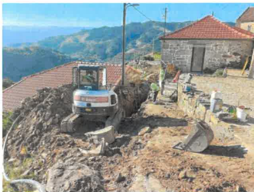
Foto 5 - FECHO DE SISTEMAS DE ÁGUAS RESIDUAIS EM VÁRIOS LUGARES DOS MUNICÍPIOS
