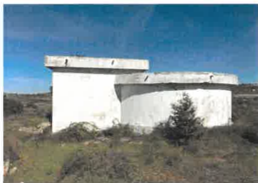
FOTO 3 - RESERVATÓRIO ESTEVAIS - TORRE DE MONCORVO
