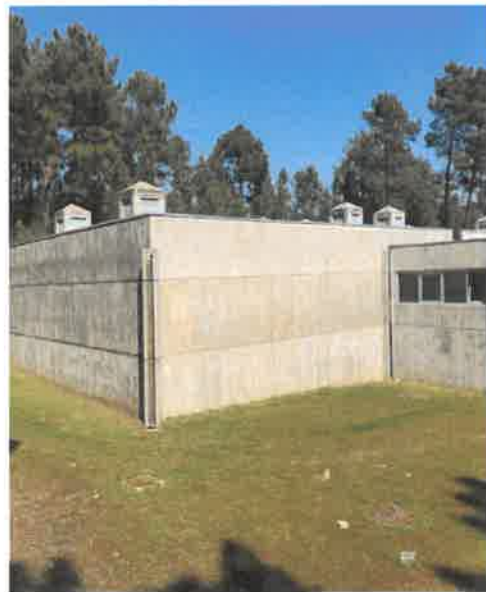
FOTO 1 - RESERVATÓRIO DE CONSTANTIM
