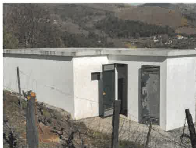
FOTO 7- RESERVATÓRIO DE TOJAIS - MESÃO FRIO
