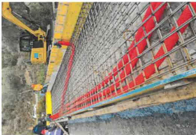
FOTO 5- EMPREITADA DE CONCEÇÃO/CONSTRUÇÃO DE ETAR'S MBR'S - LOTE 1
