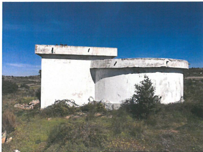
Foto 5 - Reservatório de Estevais
