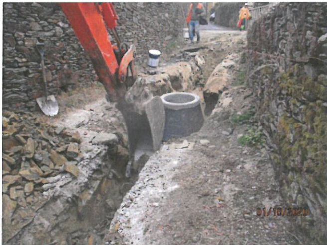
Foto 2 - Instalação de coletores - Drenagem de Esgotos no Vale da Campeã
