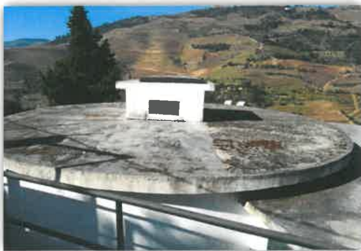
FOTO 2 - RESERVATÓRIO DE COVELINHAS
