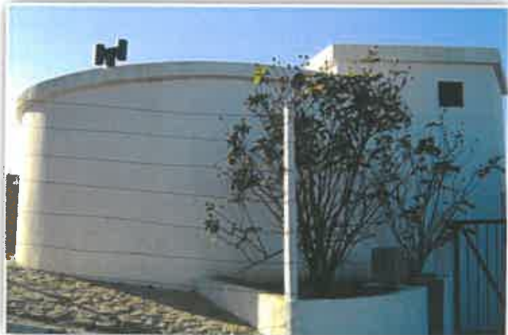
FOTO 1 - RESERVATÓRIO DE VILARINHO DE S. ROMÃO
