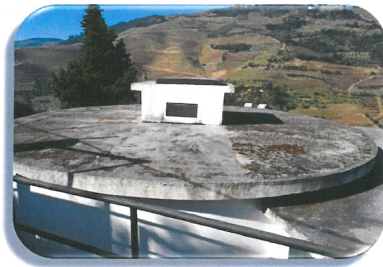
Foto 1 - Reservatório de Covelinhas
